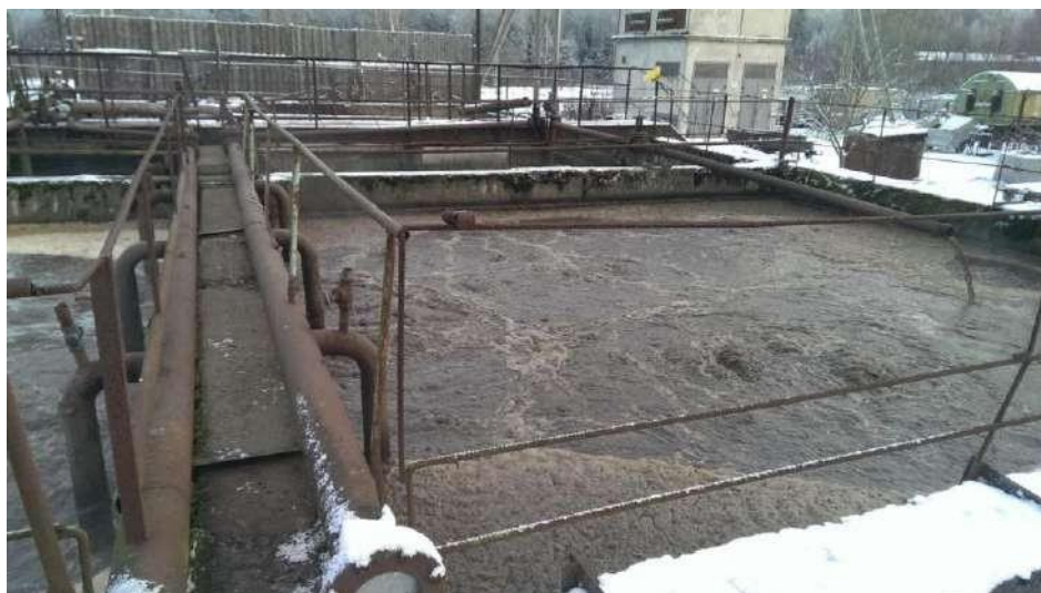
Рисунок 15. Аэротенки биологической очистки КОС пос. Щеглово
