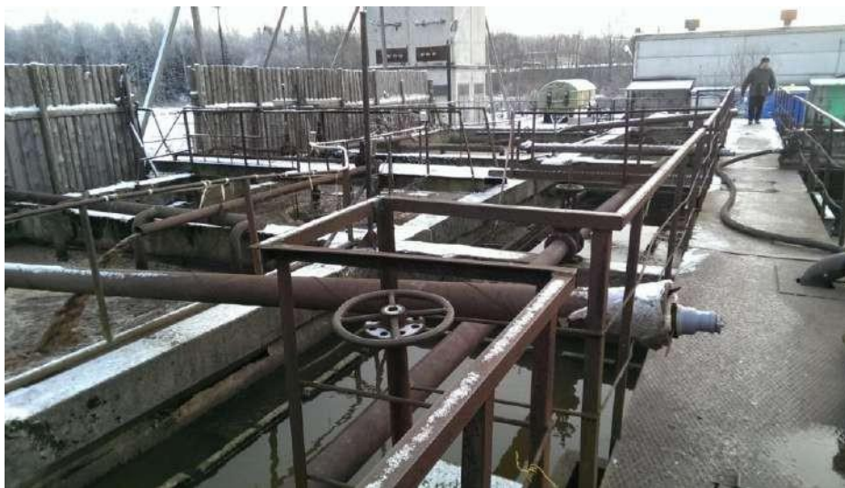
Рисунок 16. Отстойники и минерализаторы КОС пос. Щеглово
