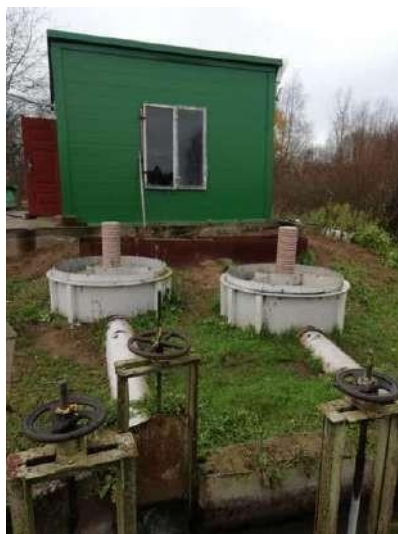
Рисунок 14. Тангенциальные песколовки
